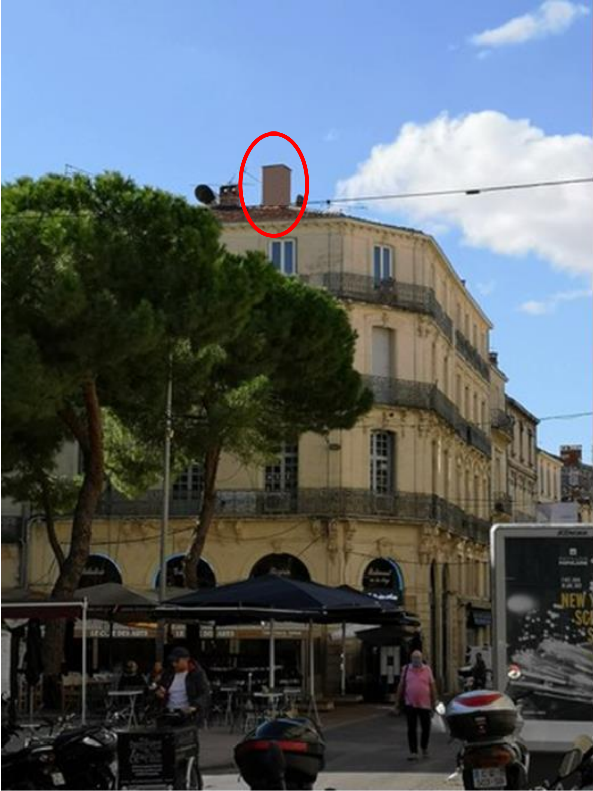
Photographies après travaux
