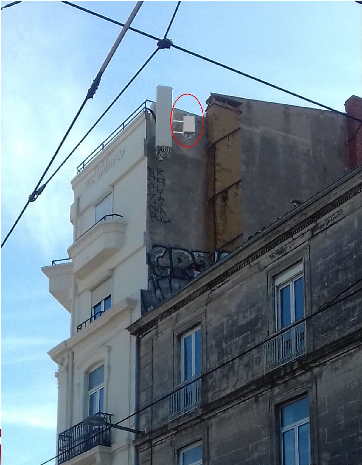
VUE 1 de près après travaux
