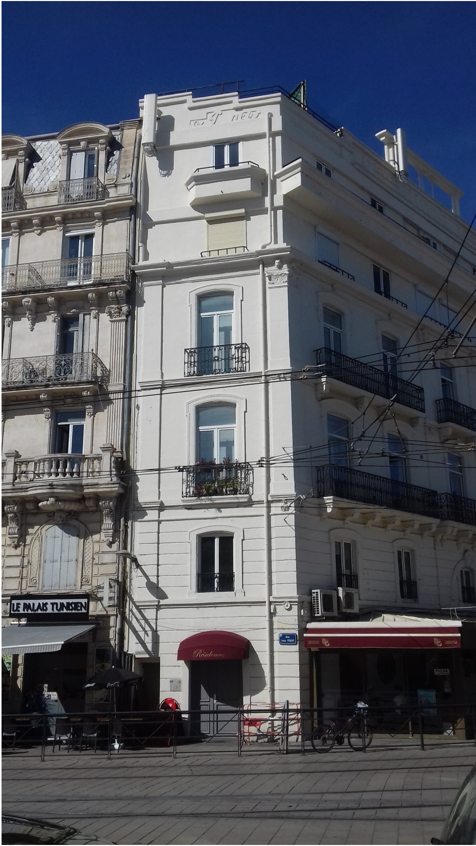
VUE 2 de loin avant travaux
