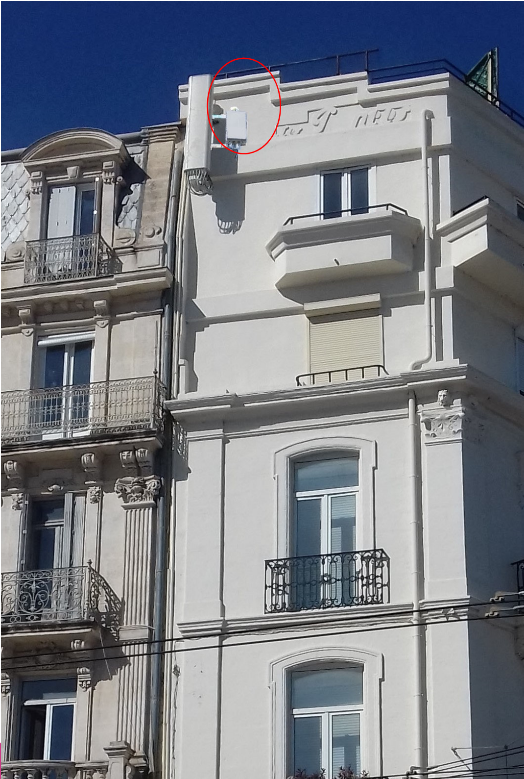
VUE 2 de près après travaux
