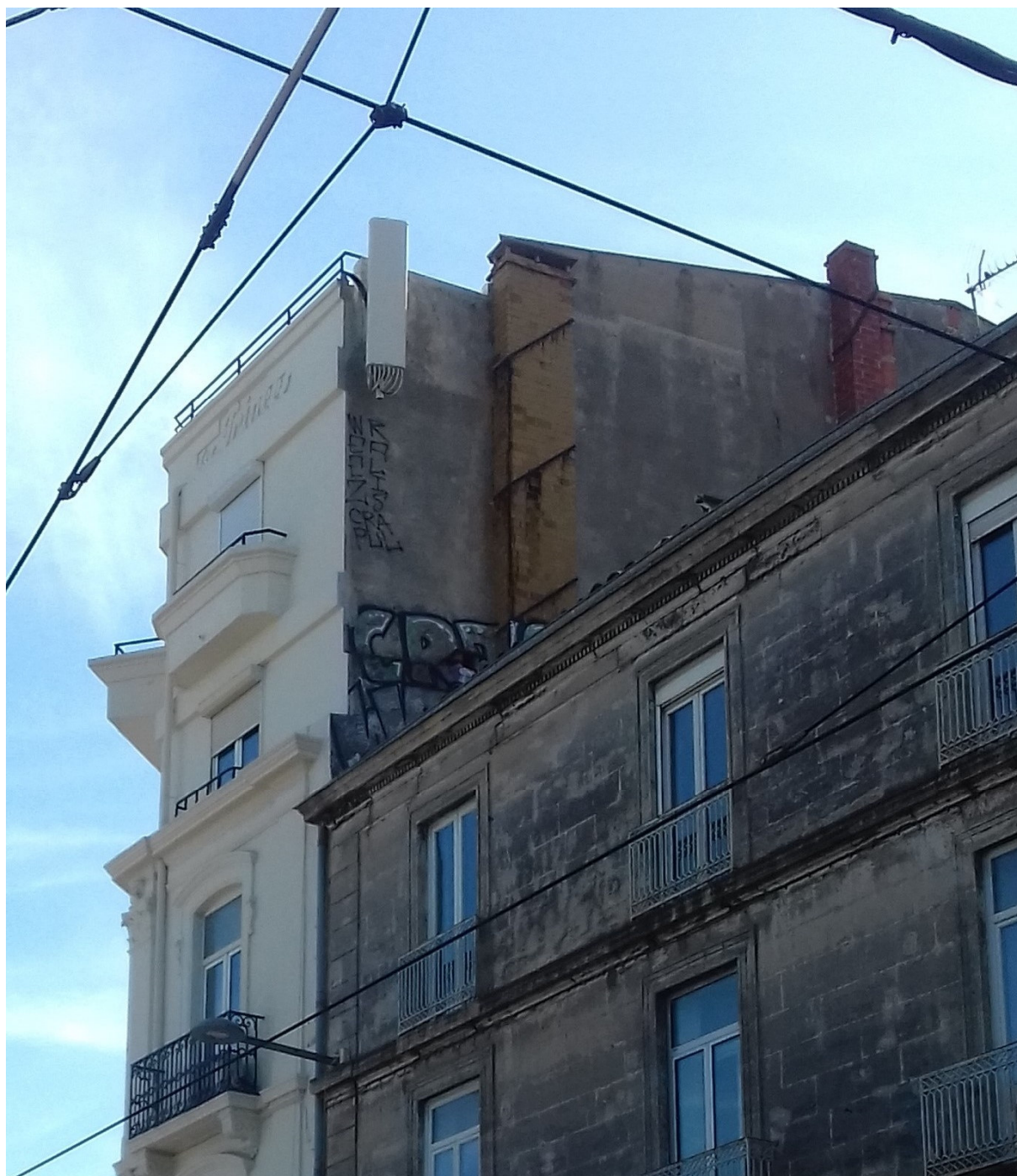
VUE 1 de près avant travaux
