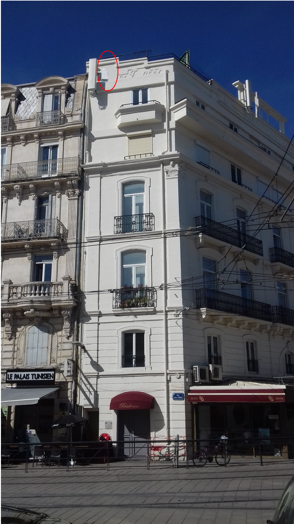
VUE 2 de loin après travaux
