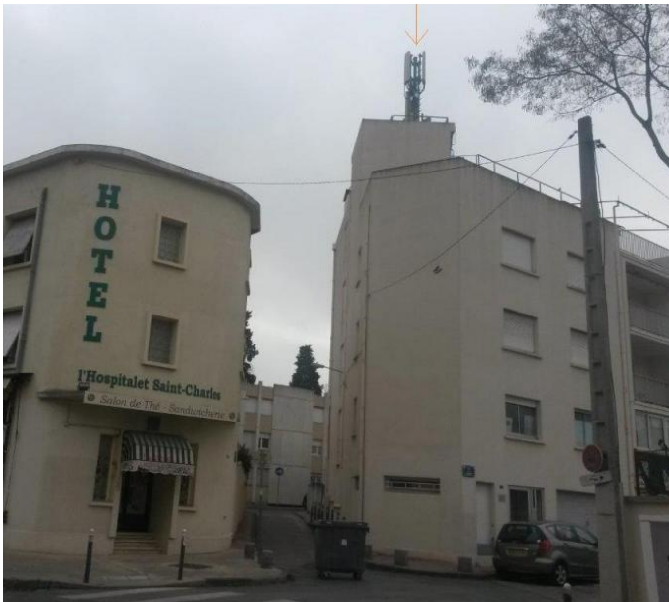
vue 2 : Vue de près.Pas de modification visuelle après le changement des antennes.
