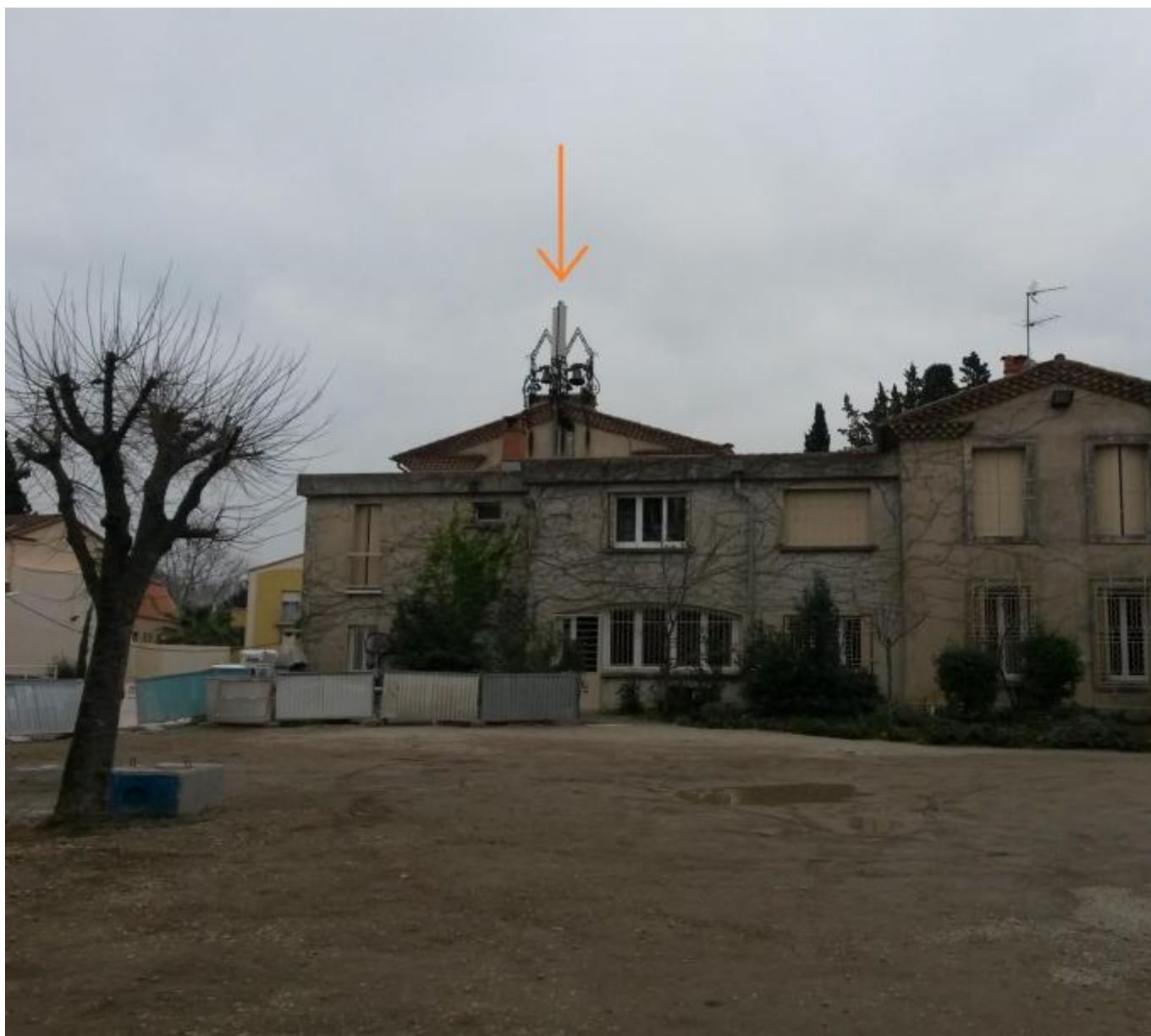
vue 2 : Pas de modification visuelle parès changement antenneaire.
